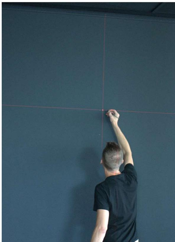
Laserstrahlausrichtung für die Platzierung der Emailletafeln
